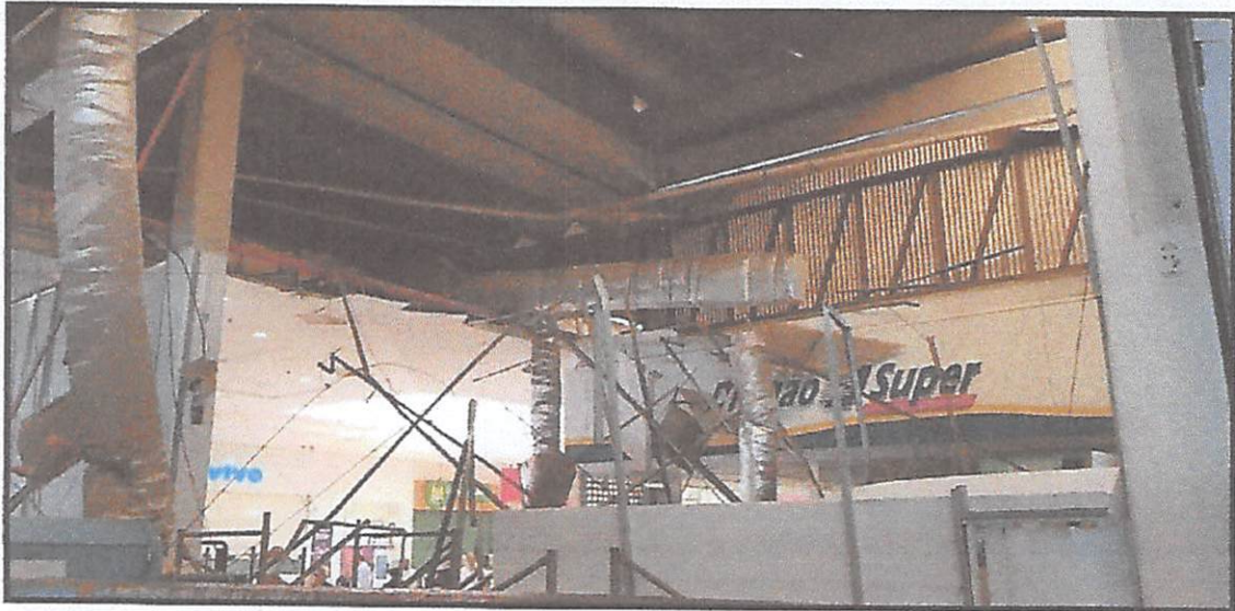
IMAGEM 01 – Duto de ar condicionado deslocado com a ocorrência do deslocamento do forro de gesso. (Estruturas preservadas)
