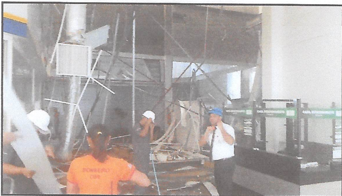
IMAGEM 02 – Remoção do duto de ar condicionado
