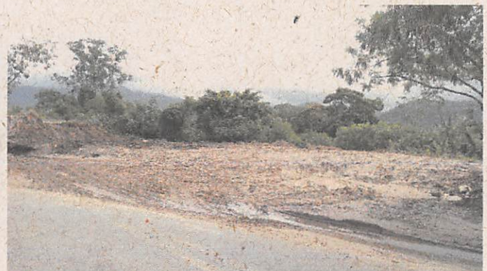
Área já limpa (horário almoço sem maquinas)
