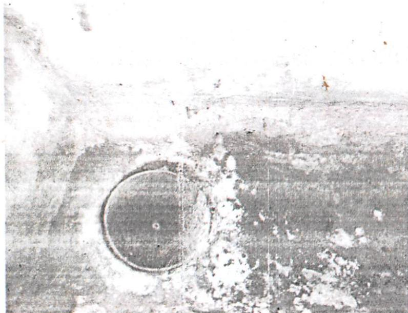
Foto 11: Detalhe do ralo da vigas calha, tubo de descida das águas pluviais.
