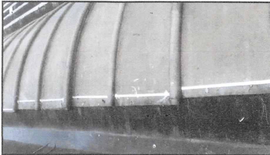
**IMAGENS 05 e 07 – (SERVIÇOS EXTERNOS)** Reposição localizada de 01 domus, porém com reforço preventivo neste e nos demais. Estas peças eram parafusadas diretamente na telha de concreto, o que permitiu vida útil por duas décadas. Agora, são fixadas com uma proteção de fitas direcionais metálicas, evitando ruptura e rasgos nos domus.
