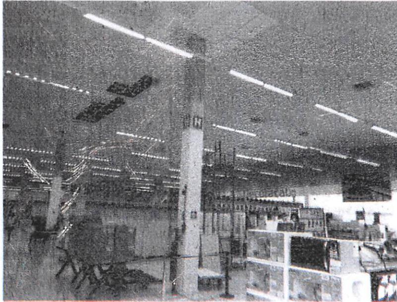
**Foto 2: Detalhe geral do piso interno, paredes e pilares sem apresentar patologias tais como, recalque, desaprumo, trincas, afundamento, etc., forro parcialmente danificado.**
