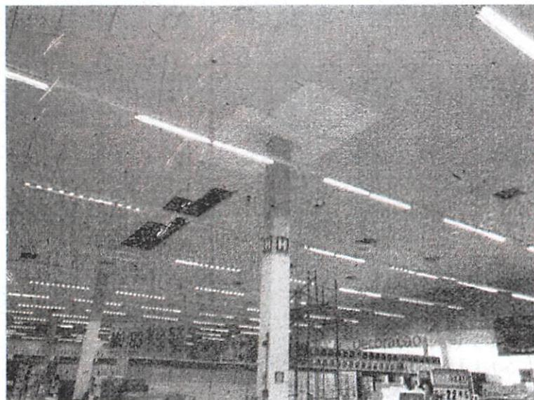
Foto 1: Vista geral da edificação, pilares, sem apresentar patologias tais como, recalque, desaprumo, trincas, afundamento, etc.
