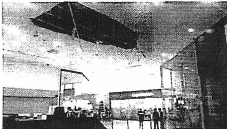
IMAGEM 2 - Deslocamento de placa de gesso em área de circulação, decorrente de infiltração, mas sem sequer comprometer equipamentos de hidráulica embutidos
