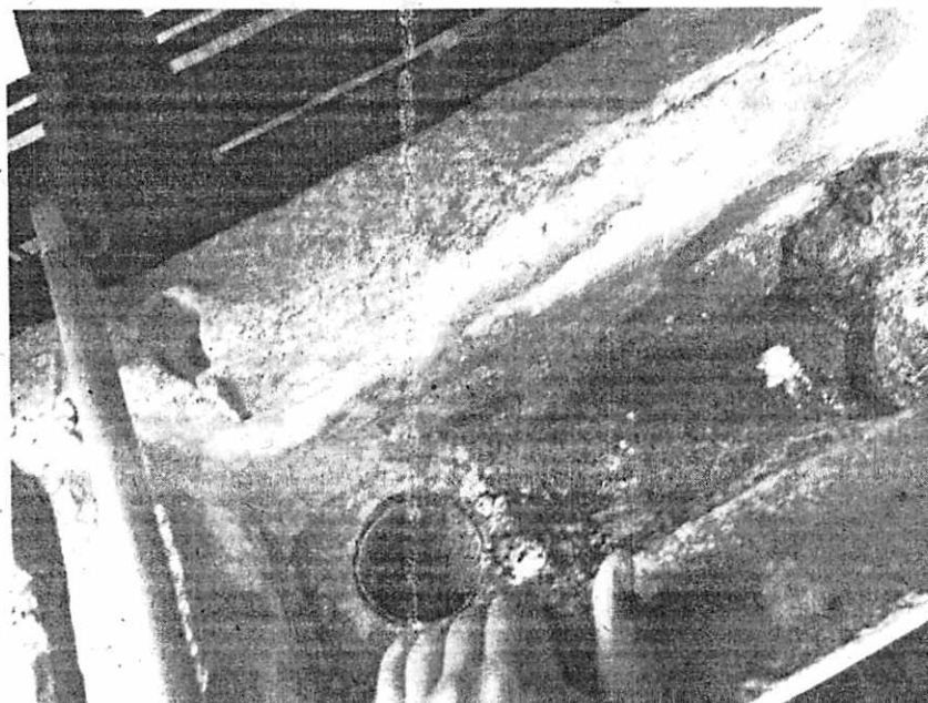
Foto 10: Vista do ralo, tubo de descida das águas pluviais na parte interna da viga calha.
