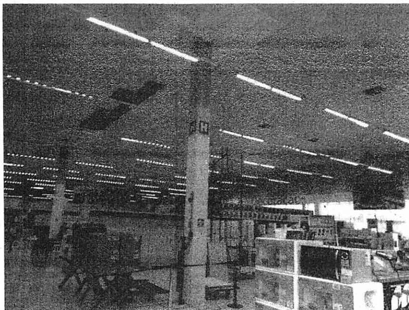
Foto 2: Detalhe geral do piso interno, paredes e pilares sem apresentar patologias tais como, recalque, desaprumo, trincas, afundamento, etc., forro parcialmente danificado.
