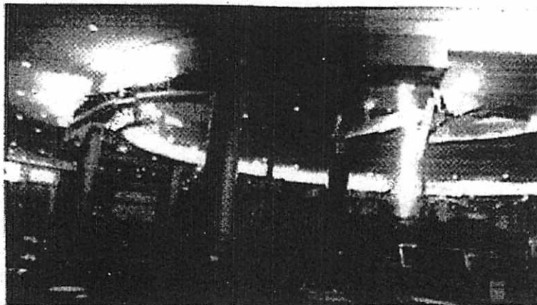
IMAGEM 1 - Deslocamento de sanca de gesso na praça de alimentação, decorrente de infiltração
