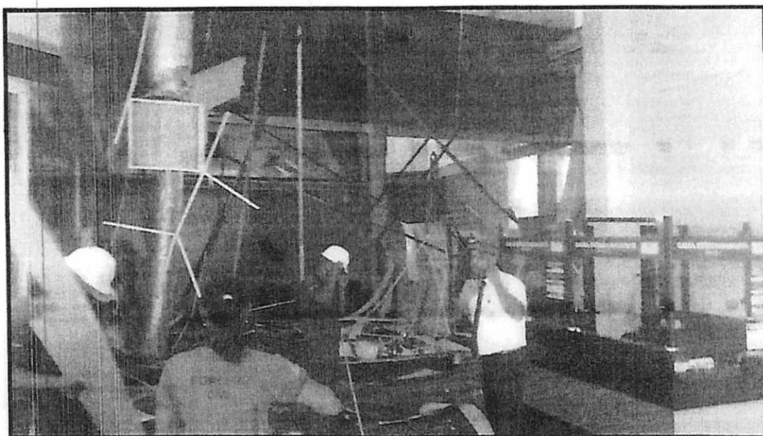
IMAGEM 02 – Remoção do duto de ar condicionado
