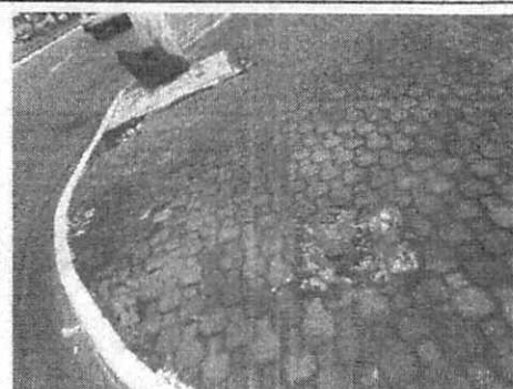
INFILTRAÇÃO PRÓX. AO POSTE.
