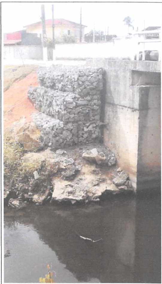
Detalhe da Lateral a montante da ponte: estrutura constituída por gabiões
