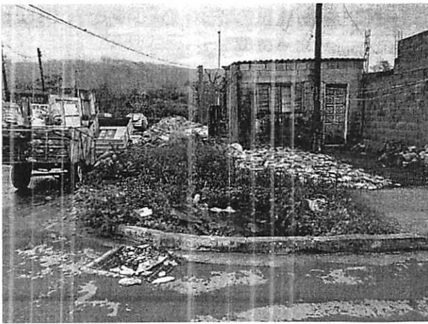
Imagem 03: notar o fechamento total da vala de escoamento pluvial
