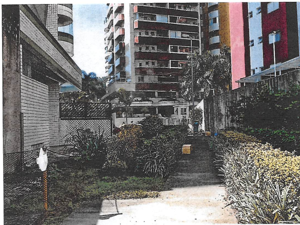
Foto 6 – Vista fundos, sentido Avenida Costa Machado.
