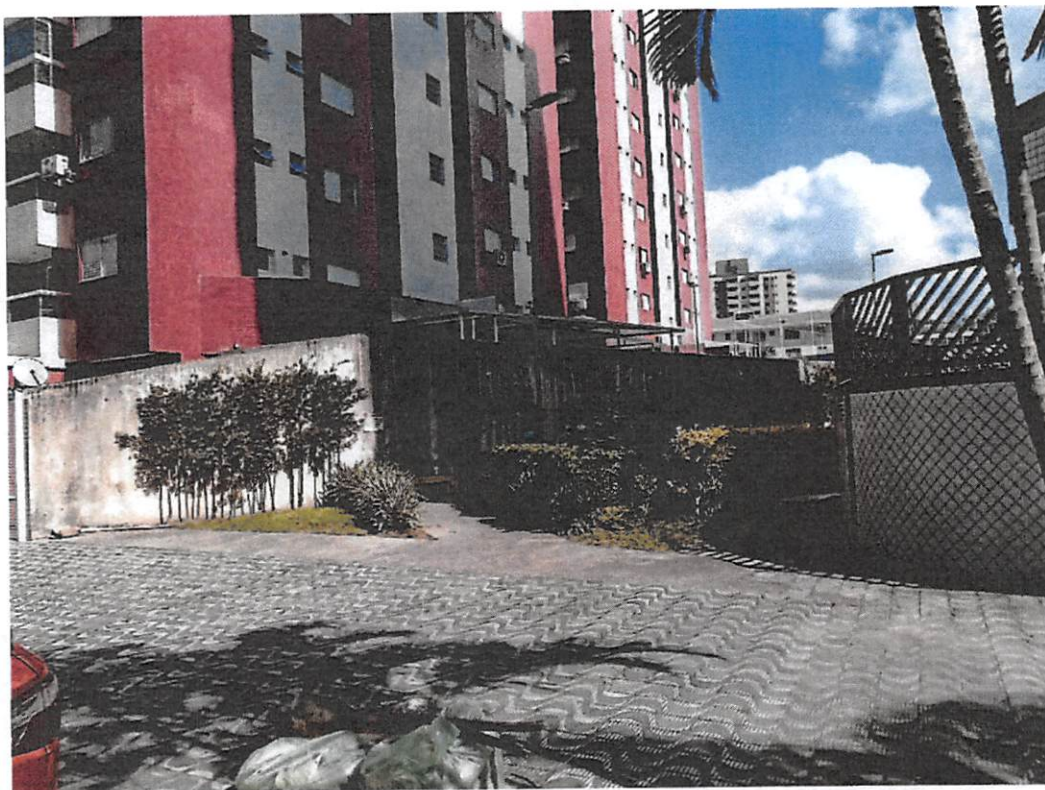
Foto 1 – Vista, frente para a Avenida Costa Machado.
