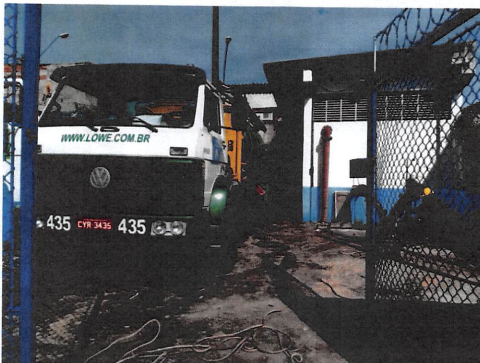
Caminhão executando limpeza do poço da EEE 2
