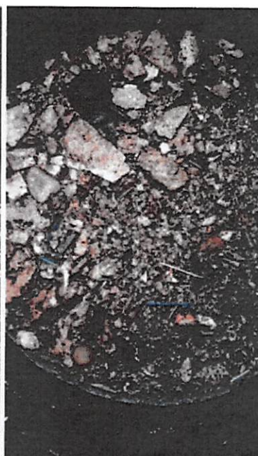
Entulho dentro do PV
