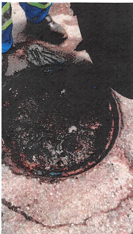
Descarte irregular de óleo (gordura)
