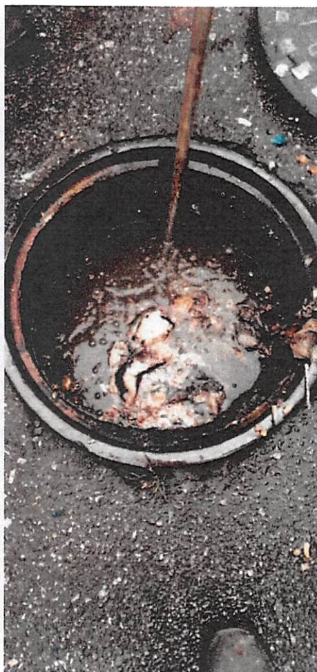
Descarte irregular de óleo (gordura)
