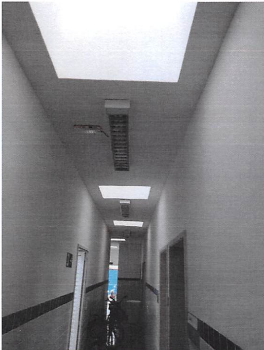
Serviços de reparo da cobertura, impermeabilização das claraboias e pintura interna.
