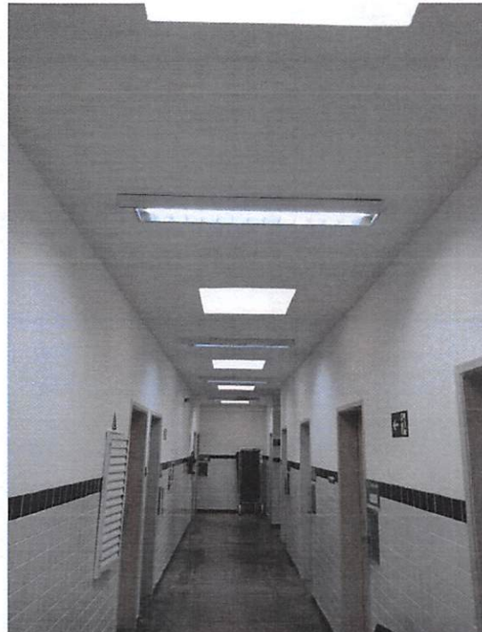
Pintura do corredor
