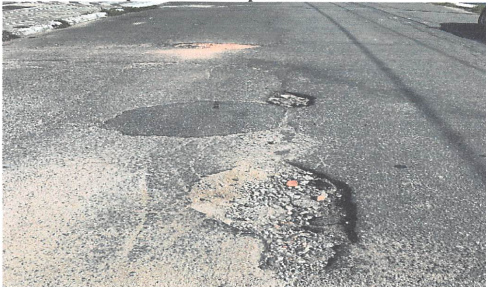
Reparo de buraco próximo ao nº 130
