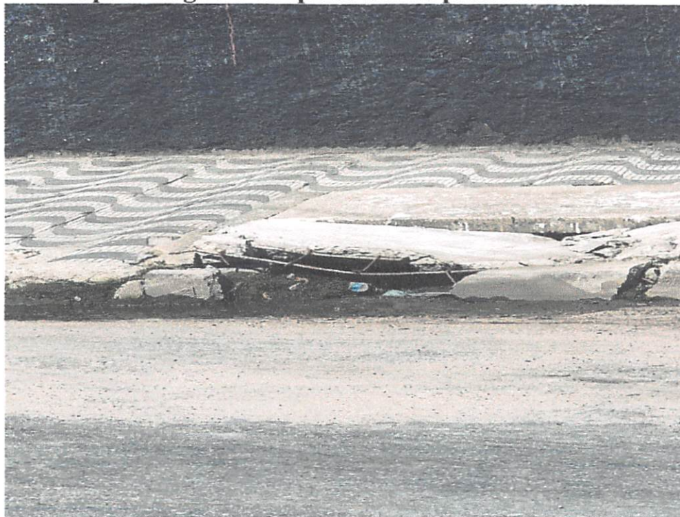
Reparo da guia e tampa do bueiro próximo ao nº 49
