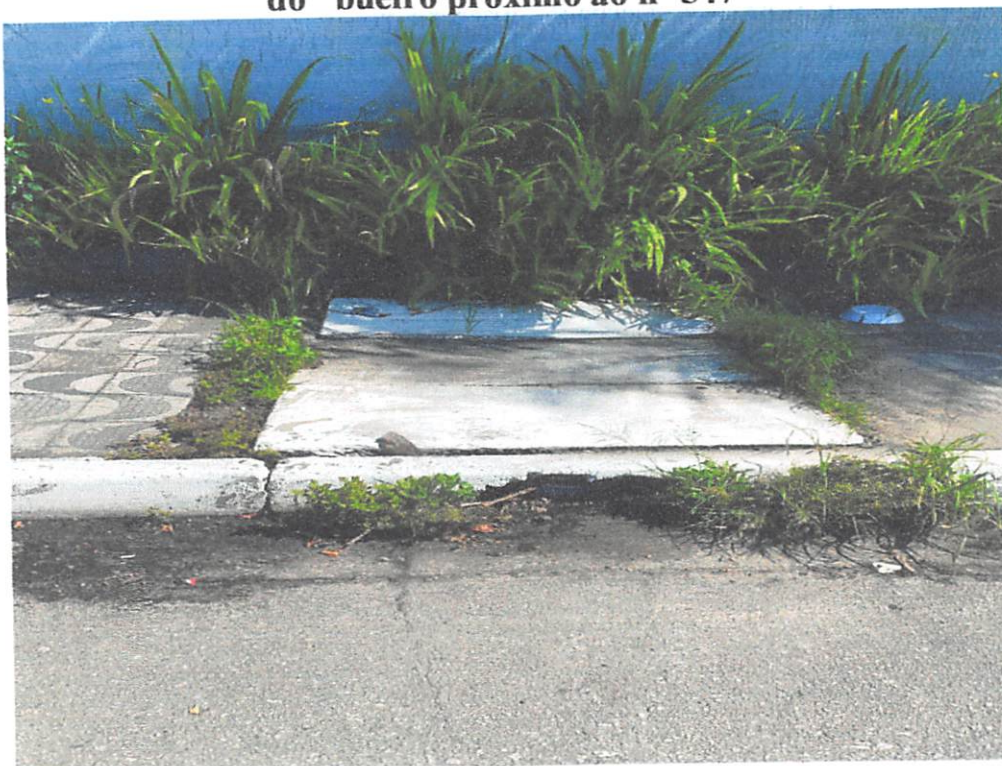
Reparo da guia Chapeu, limpeza, desentupimento e desobstrução do bueiro próximo ao nº 547
